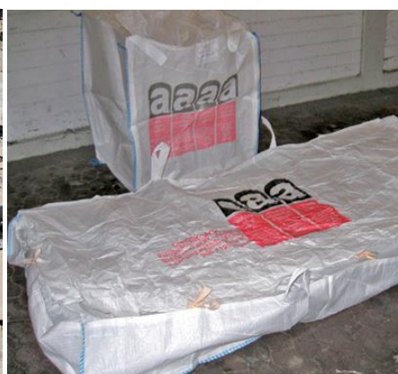
Big Bags für asbesthaltige Baustoffe
